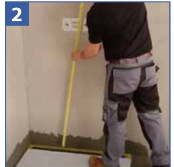
2 Relever les côtes des arrivées d'eau.
