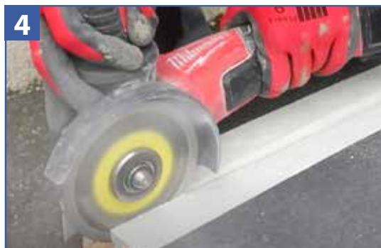
Effectuer les découpes à l'aide de disques diamant pour une découpe nette et rapide.
